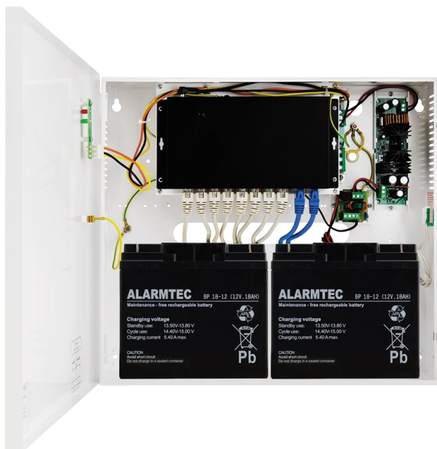
Przykładowy montaż S108-B z akumulatorem (akumulator nie wchodzi w skład zestawu)
