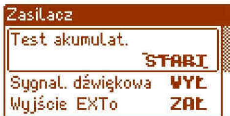
Rys. 28. Test akumulatorów – nieaktywny.
